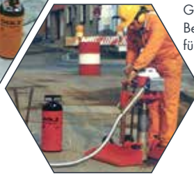
Überbohren von Wasserschiebern bis Ø 200 mm
