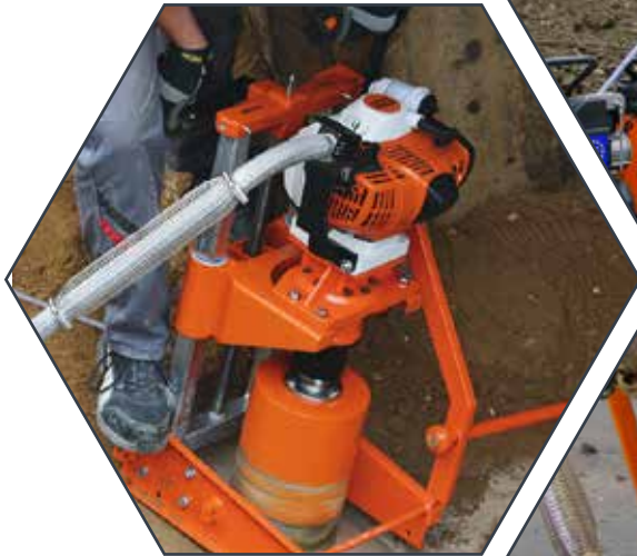
Bohren 90° am verlegten Rohr. Das Kernbohrgerät wird mit dem Rohrfuß zwischen Betonrohr und Grabenwand geklemmt. Zusätzliche Sicherung mit Erdnägeln.
