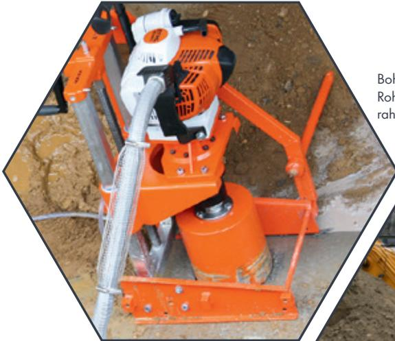
Bohren 90° am verlegten Rohr. Befestigung am Bodenrahmen mit Erdnägeln.
