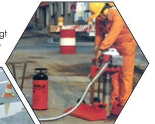
Überbohren von Wasserschiebern bis Ø 200 mm
